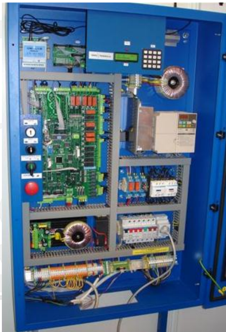
Obr. 1 - Výtahový rozváděč
